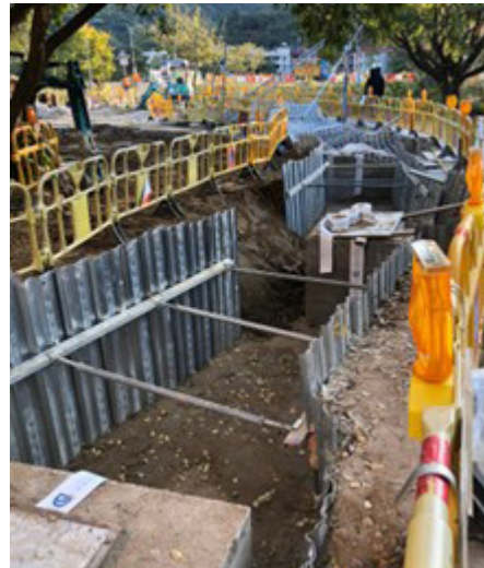
建造污水系統
