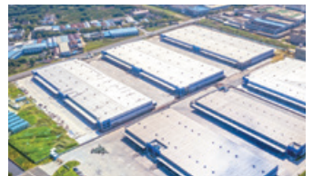
8 Wuxi Huishan Project
