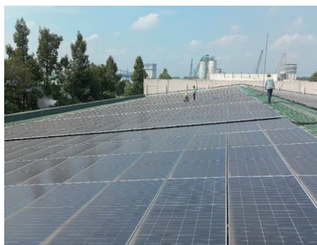
維護越南廠房的太陽能光伏板
