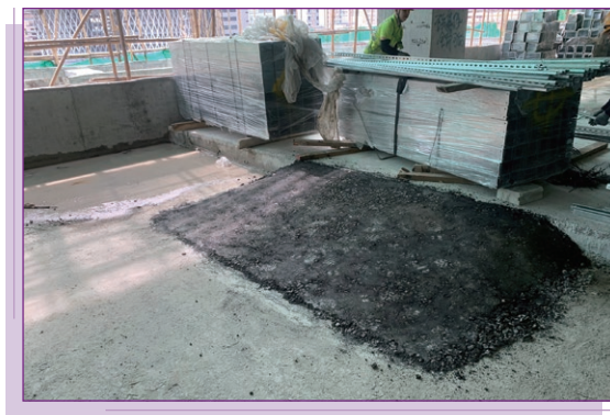
Reuse Asphalt for Pavement 重用瀝青鋪設路面
