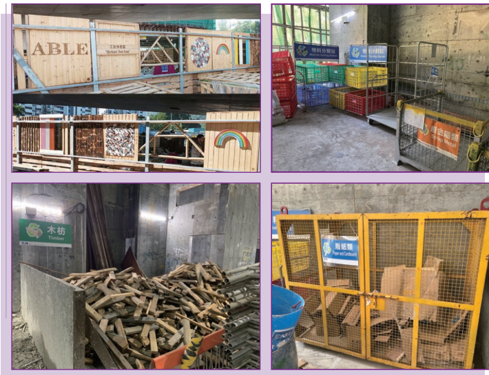
Sorting plastic, timber and metal wastes for recycling and reuse 將塑料、木材及金屬廢棄物分類，以進行回收及再利用
