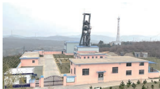
輔助豎井工地
