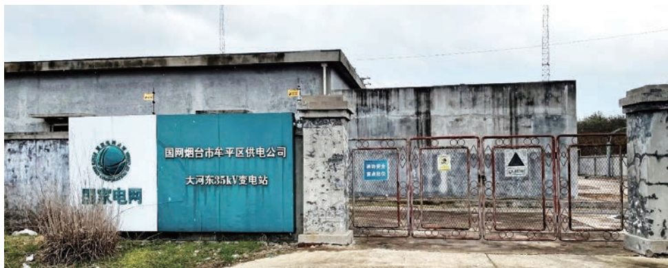
圖16-3：大河東變電站
