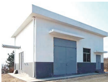
柴油發電機室
