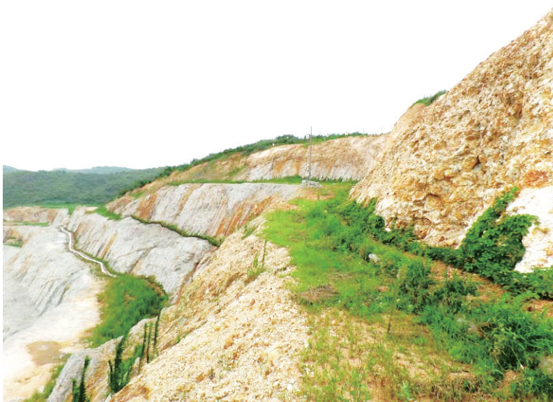
圖18-2：礦區露天礦坑壁邊坡植被重建
