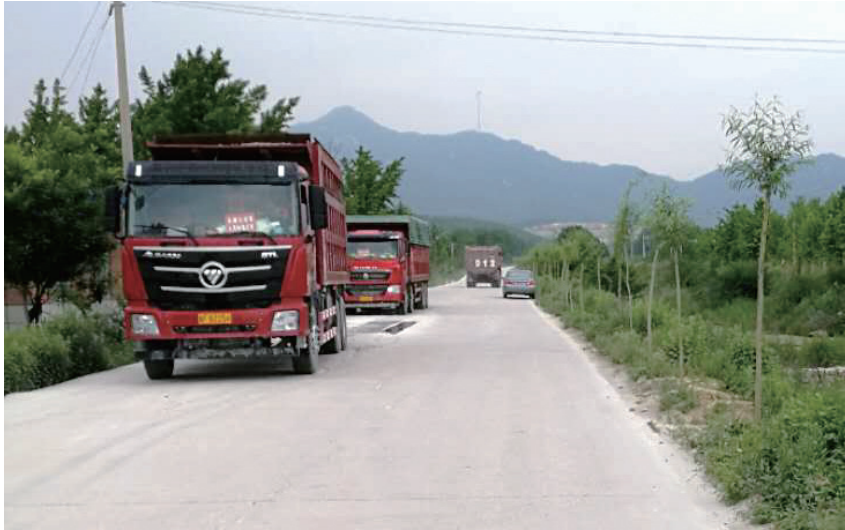
圖16-1：連接礦區與加工廠的混凝土路面
