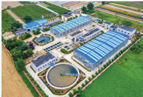
夏縣污水處理中心
