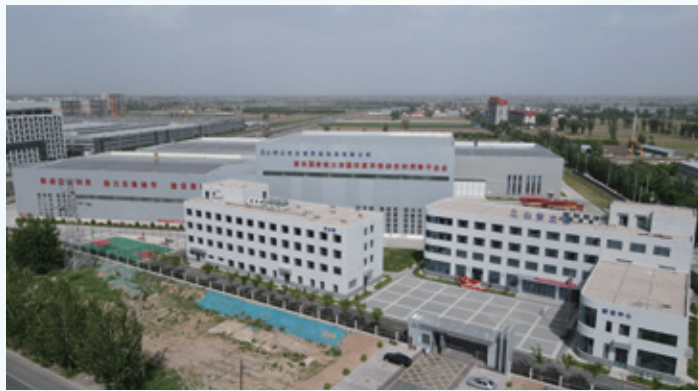
瀟河產業園區建築垃圾項目主體結構
