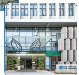
TECHNOLOGY BUILDING 2 科技大廈二期
