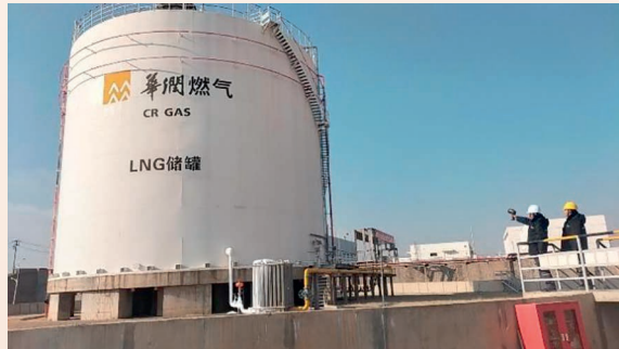
圖：燃氣設施安全隱患排查
