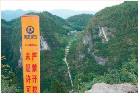
圖：奉巫線完成管道鋪設
