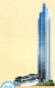
08 武漢越秀財富中心及星匯維港購物中心 WUHAN YUEXIU FORTUNE CENTRE AND STARRY VICTORIA SHOPPING CENTRE
