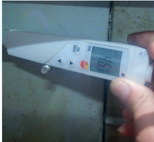
天津食品廠油炸機保溫工程 Fryer insulation project in Tianjin food factory
