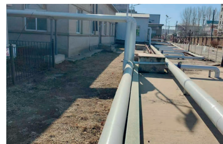
配套管道工程 Supporting pipeline
