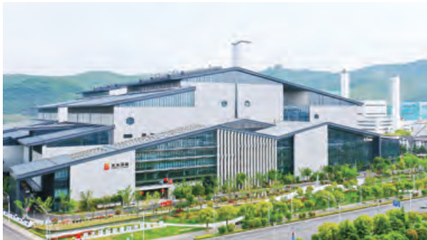
Suzhou Waste-to-energy Project 蘇州垃圾發電項目
