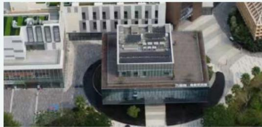
天津金茂匯在西廣場設置光伏廊架，頂部安裝太陽能光伏板，年發電量 8 萬千瓦時，每年可減少 76.8 噸二氧化碳排放。
