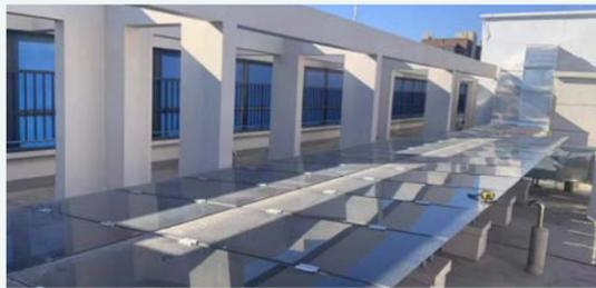
三亞金茂灣城市會客廳項目屋頂共設置碲化鎘光伏組件 196 塊，總安裝功率 20.58 千瓦，所發綠色電力全部由空調室外機配電箱消納。項目每年可節約標準煤 8.69 噸，減少二氧化碳排放約 26.51 噸、二氧化硫排放 176.7 千克、氮氧化物排放 59.85 千克。
