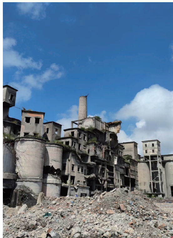
水泥廠錦誠花園改造前
