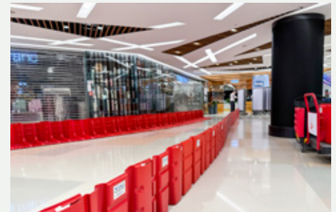
安裝防洪屏障及沙包避免水浸
