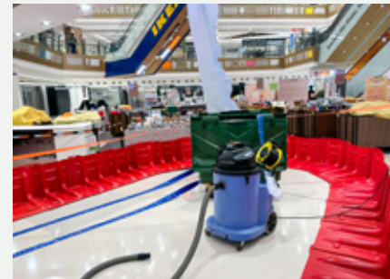
使用 660 公升的容器及潛水泵排水
