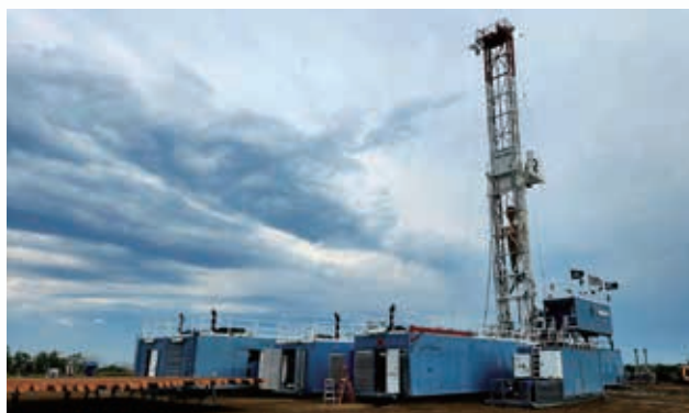
用於新井鑽探的鑽機
