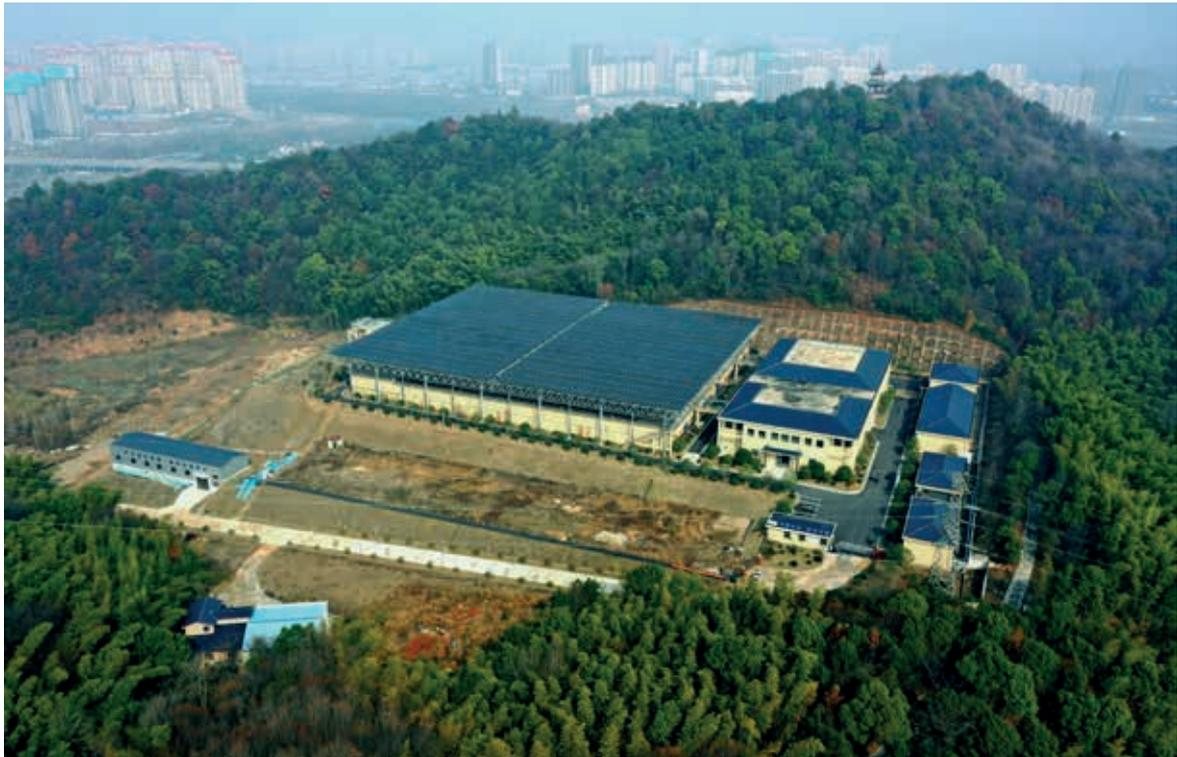
寧鄉市南太湖水廠的光伏設備安裝在反應池和平流沉澱池上方
