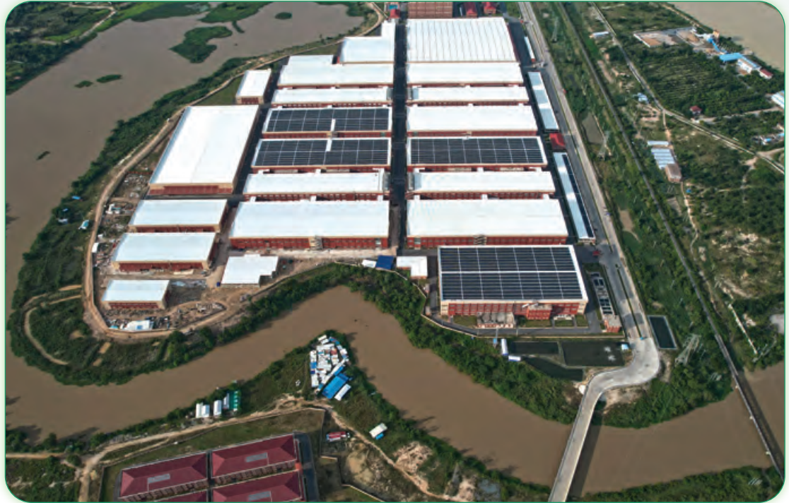
柬埔寨廠區的太陽發電板 PV panels in the Cambodia factory
