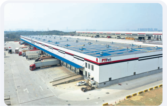
長沙物業 – 已安裝太陽能板
