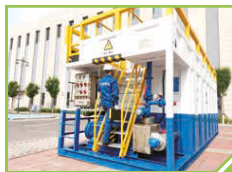
2022 年，固井作业现场完成 11 台混合水罐斜梯改造并投入使用，减少员工上下水罐跌落风险，保障作业人员安全
