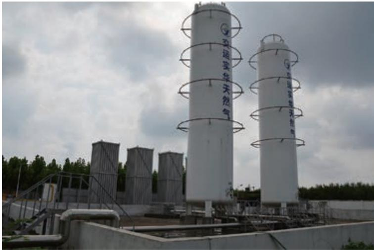
為確保可取得及持續向管道天然氣終端用戶供應管道天然氣，我們設置液化天然氣調峰站作為緊急情況、意外、突發需求飆升、出現暫停或中斷下的管道天然氣後備供應源。根據灼識諮詢，在管道天然氣供應高峰期，將液化天然氣轉化為管道天然氣以穩定中壓管道的大氣壓力，是天然氣營運商為確保管道天然氣銷售的連續性而採取的切實可行解決方案。我們的液化天然氣調峰站自液化天然氣供應商的氣罐接收液化天然氣及將液化天然氣氣化為管道天然氣。管道天然氣繼而於進入我們的城市管道網絡前透過調壓器輸送作後續輸送予我們的管道天然氣終端用戶。計及包括管道壓力、用戶需求及季節性等因素後，我們的液化天然氣調峰站的最高氣化容量約為每小時10,000.0立方米。截至2019年、2020年及2021年12月31日止年度以及截至2022年4月30日止四個月，分別約有742.4噸、1,700.8噸、3,994.4噸及4,688.2噸液化天然氣轉化為管道天然氣並供應予管道天然氣終端用戶。液化天然氣轉化為管道天然氣的平均轉化率約為每1,400.0立方米一噸。
