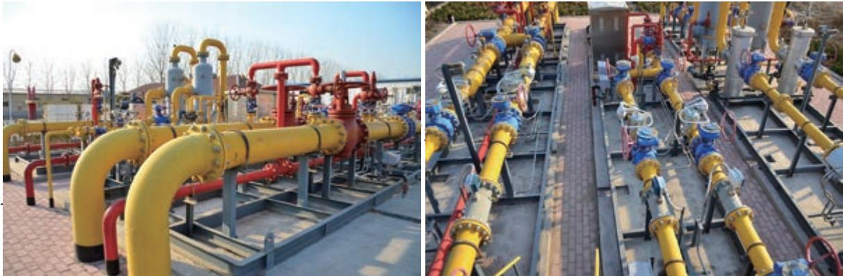
我們的城市門站位於我們的經營區域，其為我們透過長途輸送管道從供應商接收管道天然氣的通道。我們在城市門站計量及核實自供應商接收的管道天然氣容量。為安全起見，我們亦將管道天然氣的氣壓從次高壓降至中壓，然後輸送到我們營運的較低壓力水平的城市管道網絡。管道天然氣之後經過清洗及過濾以消除雜質，並以可輕易檢測但無害的成分加臭，以便我們的管道天然氣終端用戶及公眾對天然氣洩漏有所警惕。我們的城市門站配備過濾器、燃氣錶、調壓器、加臭器及閥門。
