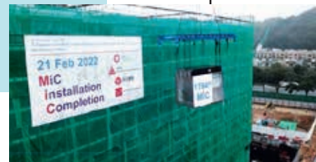
階段 5 於 2022 年 2 月完成組裝第 1,764 件獨立組件
