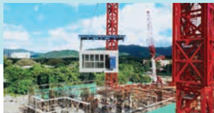
階段 4 MiC 模組於工地安裝
