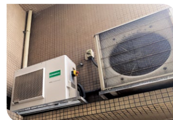
已更換的新分體式冷氣機
