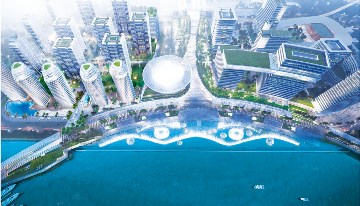
珠海世茂港珠澳口岸城
